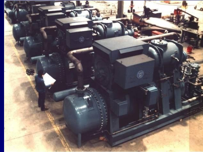
Warm Helium Compressors, ~5.2 MW Qty 3, 600 HP ; Qty 3, 2250 HP
